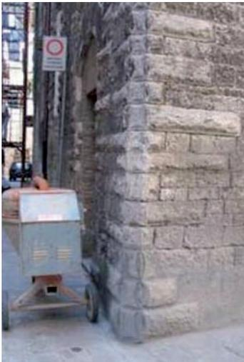
**Figura A.3** *Cantonale realizzato a regola d'arte in grado di garantire un efficace ammassamento fra le due pareti d'angolo. Gli elementi di collegamento sono costituiti dalle pietre più lunghe disposte a pettine in modo da entrare, alternativamente, nelle due pareti d'angolo.*
