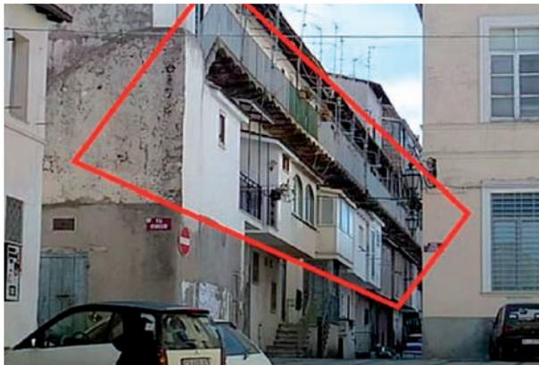
**Figura A.11** Superfetazioni sospese dovute probabilmente all'edificazione dei balconi al primo livello.
