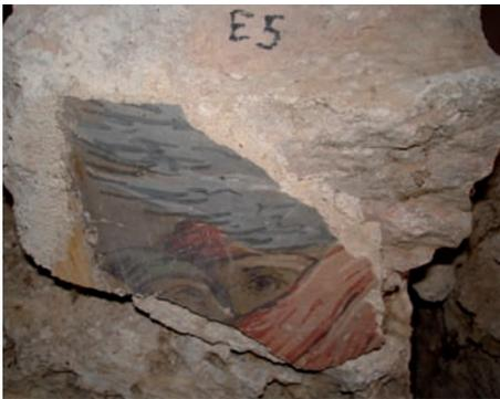
**Figura 6.1.5** Frammento del muro in pietra crollato. Sul concio è chiaramente visibile il frammento di affresco ancora adeso alla pietra e l'indicazione su di essa del codice identificativo della posizione nella griglia di riferimento.
