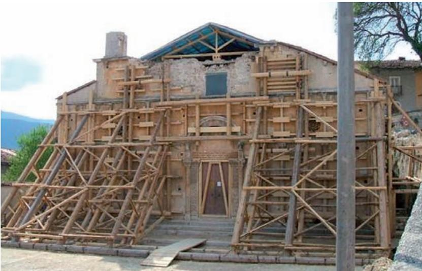
**Figura 3.** Chiesa di Bazzano (AQ), sisma del 2009. Martellamento della trave di colmo della copertura con espulsione della parte sommitale della facciata e crollo di parte della copertura.
