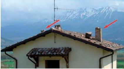
**Figura A.13** *Ribaltamento di elementi non strutturali dovuto al sisma (Abruzzo, 2009)*
