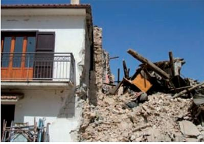
**Figura A.19** *Danni sismici prodotti dal probabile martellamento fra edifici adiacenti. Si noti il doppio muro a confine. La fotografia si riferisce all'abitato di Onna (AQ) dopo il sisma del 2009. L'edificio a sinistra è in blocchi di calcestruzzo con malta cementizia, quello a destra in pietrame irregolare e malta di cattiva qualità.*
