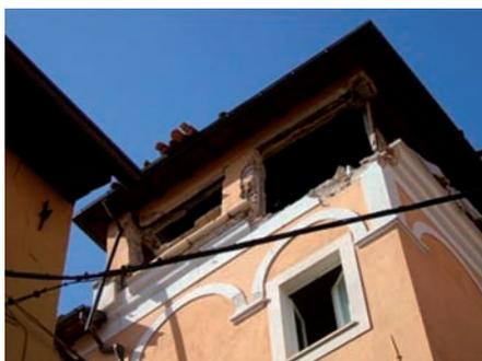
**Figura A.12** *Danni in seguito ad evento sismico a causa di variazione di rigidezza da un piano all'altro (L'Aquila, 2009).*
