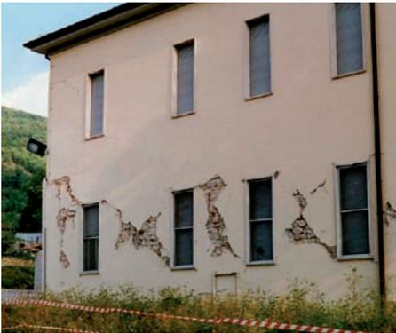
**Figura A.6** Lesioni sismiche di taglio.
