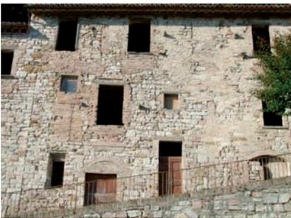
**Figura A.9** *Aperture disposte in modo irregolare, verticalmente non allineate. Non risulta possibile trovare una significativa area di muratura resistente continua da cielo a terra.*
