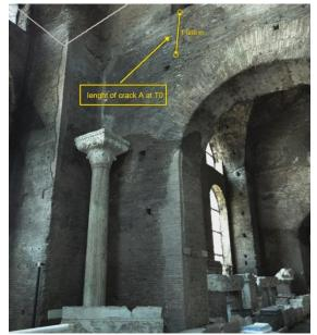
Fig. 1 Terme di Diocleziano (Rome): lenght of crack A at T0 © Vigili del Fuoco
